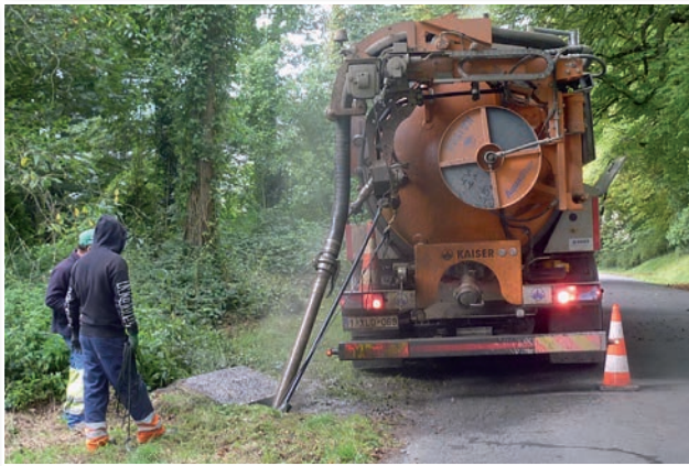
Curage des égouts en collaboration avec un sous-traitant
