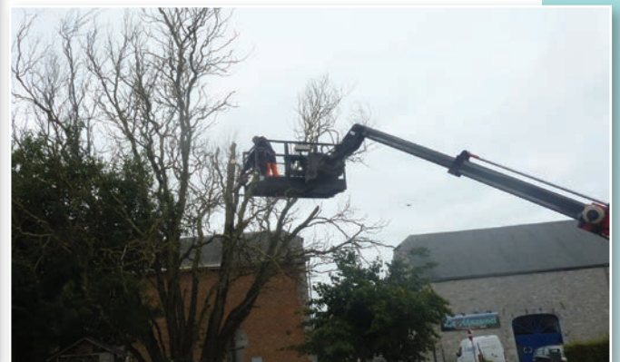
Travaux d'élagage et d'abattage
