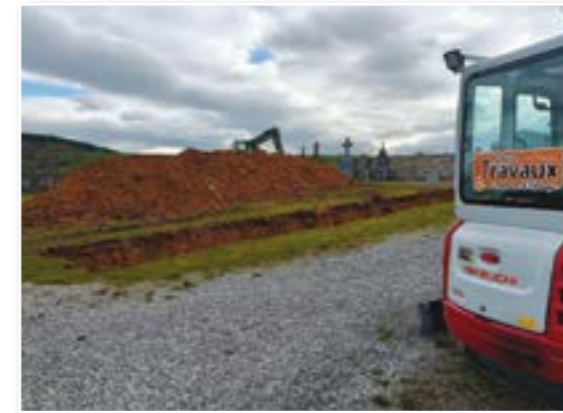
Chantier d'exhumation dans les cimetières en collaboration avec le SPW
