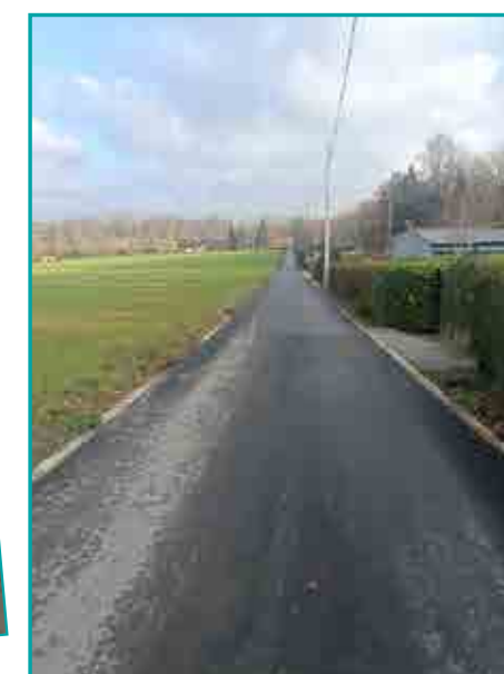
Un exemple de suivi d'un chantier « voirie » : une nouvelle voirie au Domaine de Miaflower
